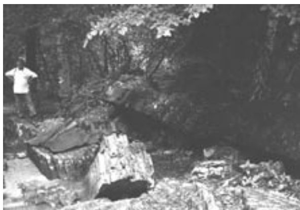
Här syns resterna efter den betongbunker i vilken Stauffenbergs bomb detonerade den 20 juli 1944.
