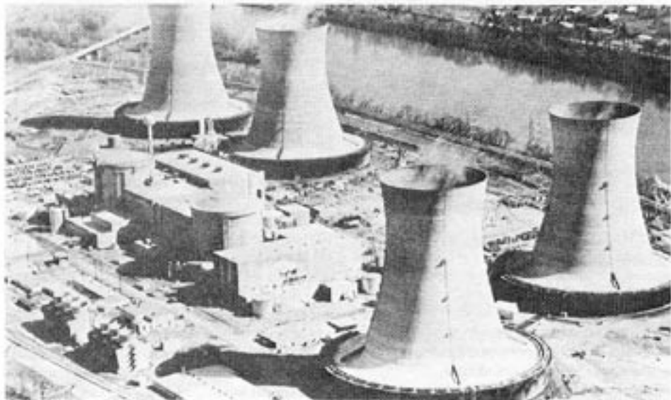
Kärnkraftverket vid Harrisburg — som utlöste den svenska folkomröstningen.
