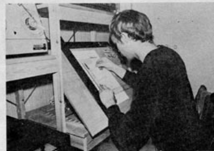
Bredvid fotosättningsmaskinen finns ett monteringsbord. Originalen klistras upp och redigeras på vita ark. Originalen görs något större än den färdiga tidningen. På reproanstalten minskas originalet med 19% för att tidningen skall bli i A4-format.
